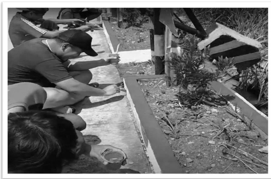
Gambar 1. Pelaksanaan Cat Area Trotoar Jalan
